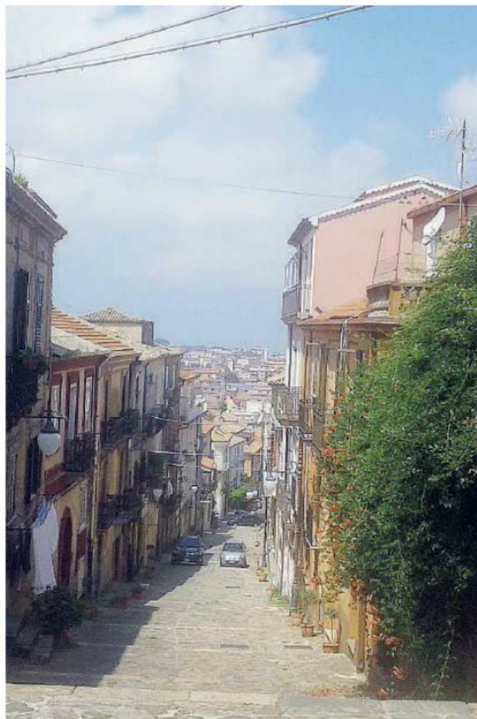
Zona Cerasarella. Oltre al problema idrico la gente denuncia l'estremo degrado
