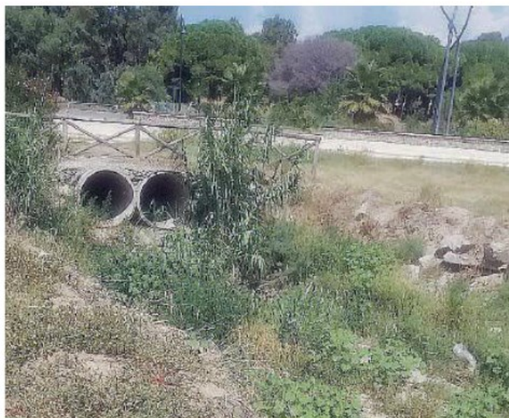
Lo sbocco. I due tubi di scarico riversano nel fosso Tiriolo le acque meteoriche raccolte a monte della strada statale 106
