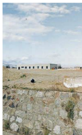
Cantiere. Castelluccio è fermo
