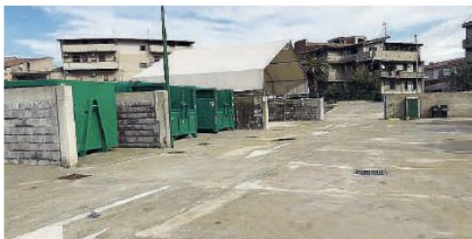
Isola ecologica di Rosarno. Ancora non è stata attivata
