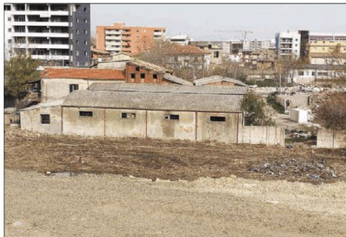
Un capannone e un tetto in eternit nell'area urbana
