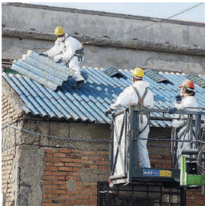
Nocivo. Alcune operazioni di bonifica dell'amianto presente sulle case
