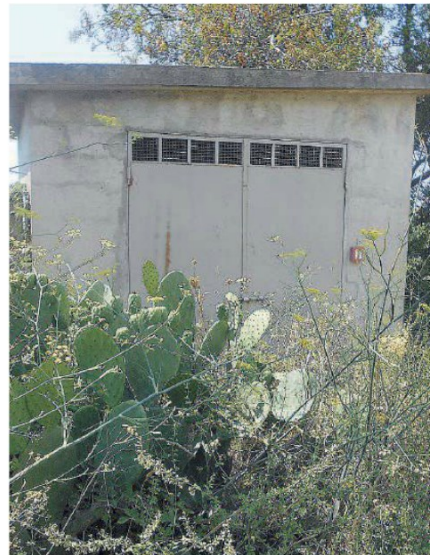
Il manufatto. La stazione di sollevamento credeva una vecchia cabina elettrica
