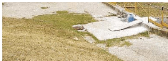
Le vasche del depuratore di Catanzaro Lido
