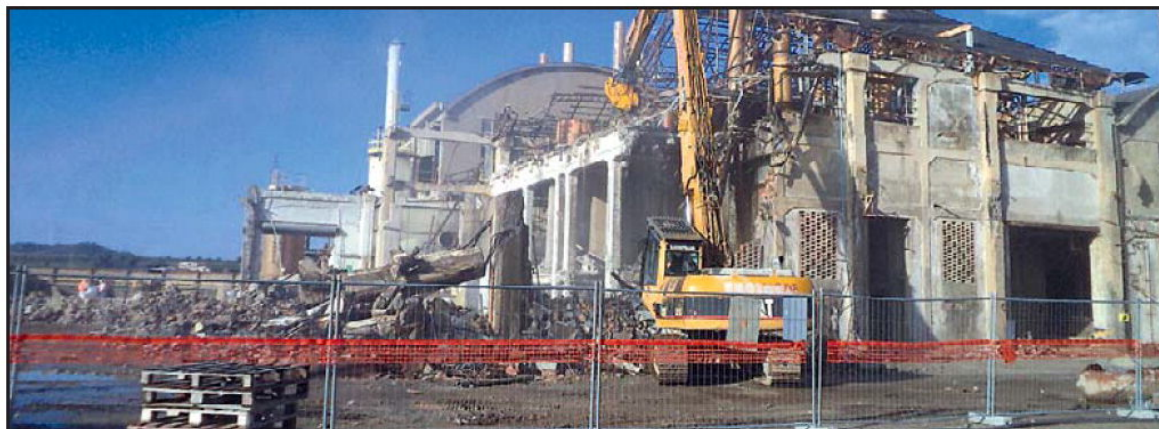
Pertusola, demolizione dell'impianto cadmio-trattamento schiume (Foto Syndial)
