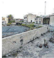
L'ex Deposito costiero. L'area deve essere bonificata
