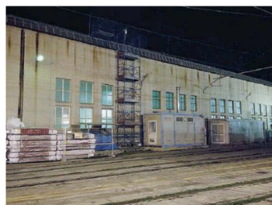
Bonifica completata. I residui di eternit imballati a Calamizzi
