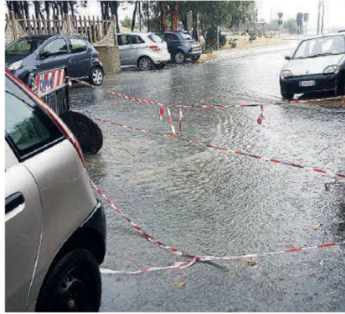
Allagamenti. Via Sant'Elena nel quartiere Lido invasa da liquami
