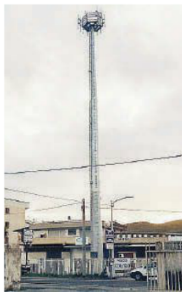
Il traliccio. La struttura tra le case
