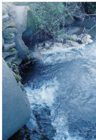
Località Murorotto. Sversamenti di acque impure nel torrente
