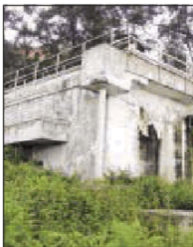
Il depuratore Acquafredda
