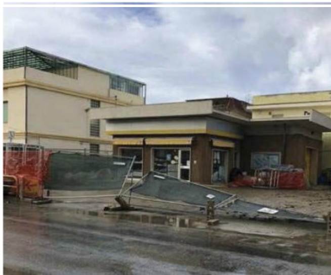
Il distributore. L'impianto di via Nazionale dove si stanno eseguendo le operazioni di bonifica resterà in standby in attesa della risposta dell'Asp
