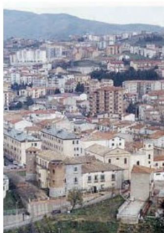
Panoramica della città di Acri. Problemi idrici in alcune frazioni
