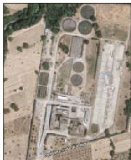
Il depuratore di Coda di Volpe
