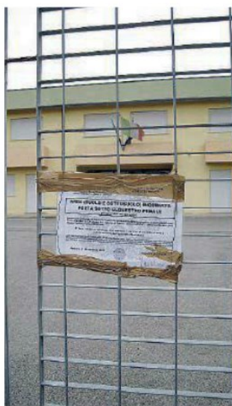
Bonifica Il piazzale dell'ex scuola
