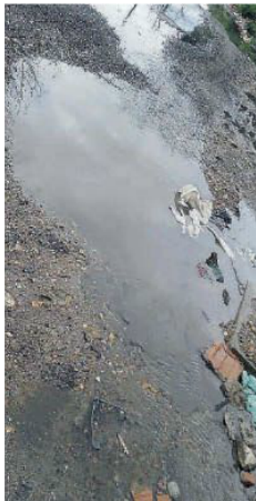
Via Ciambra. Il "laghetto" di liquami fognari
