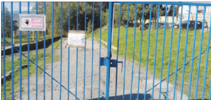
Il cancello chiuso del depuratore di Lido sotto sequestro
