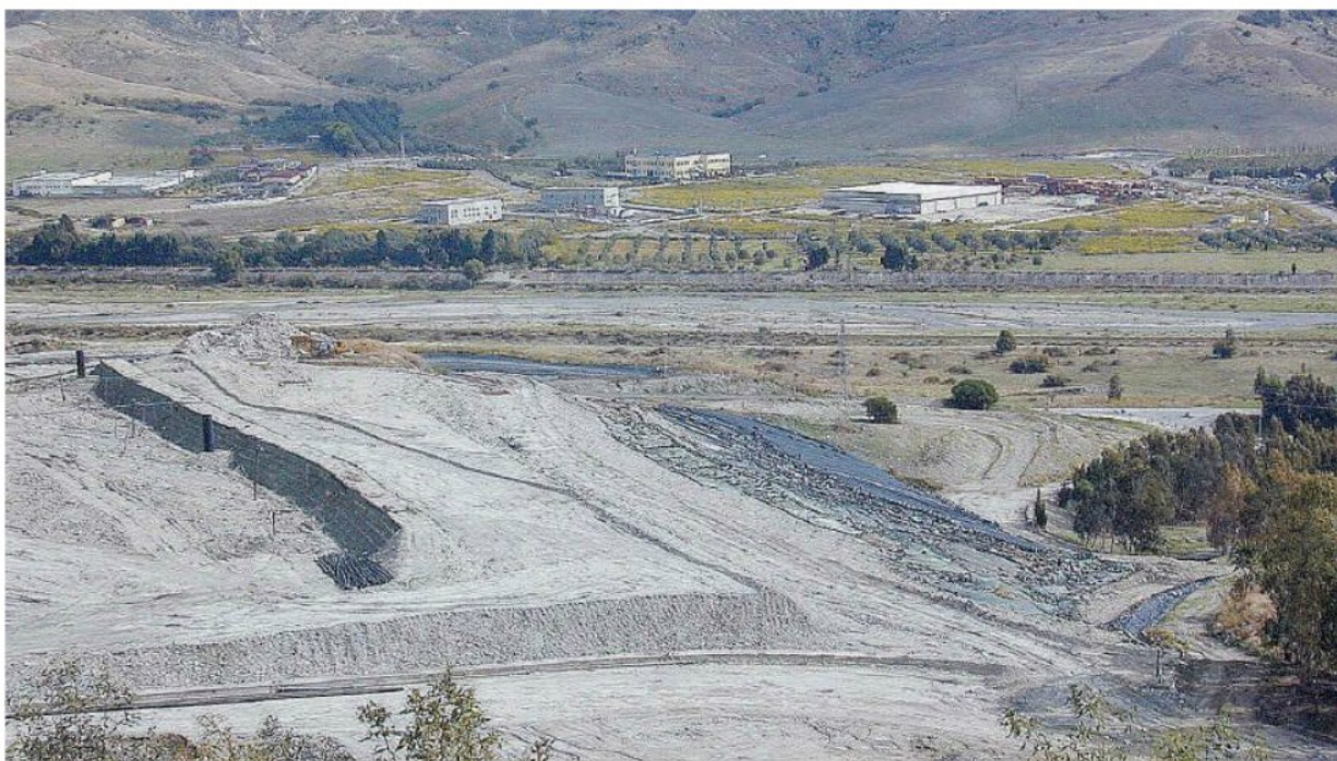
L'intervento. Il luogo per la costruzione del mega-impianto per il recupero dei rifiuti differenziati è stato individuato nell'area di Alli
