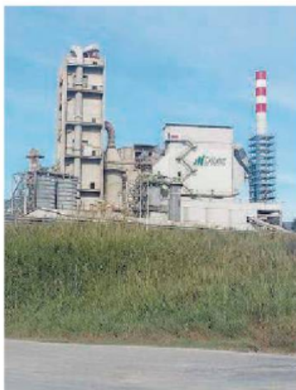
Lo stabilimento La Calme ha chiesto l'ampliamento dell'impianto
