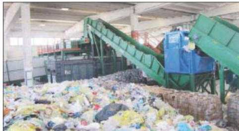
Un impianto per lo smaltimento dei rifiuti
