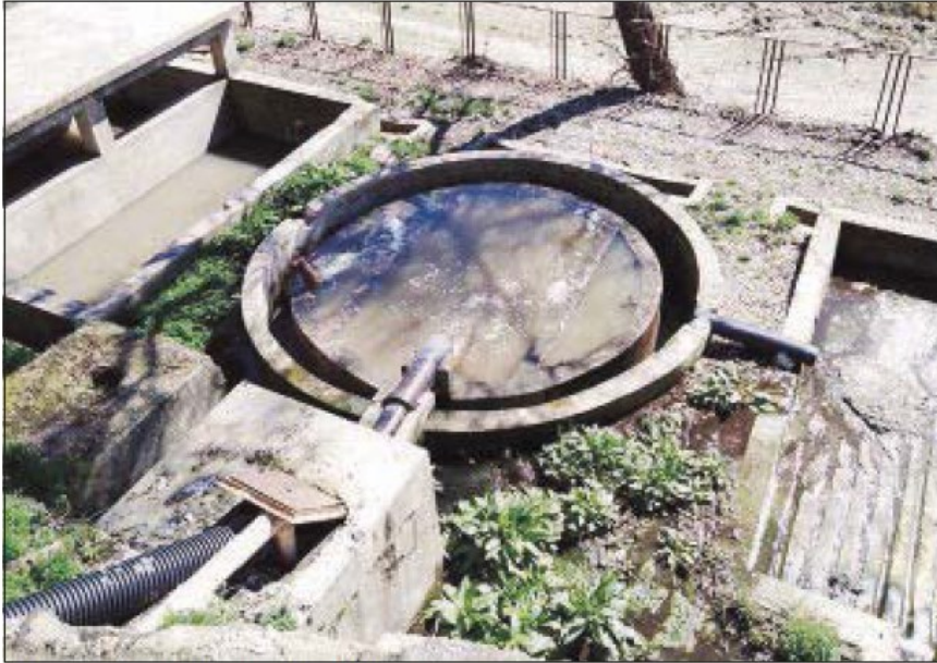
Il depuratore di località Santo Ianni
