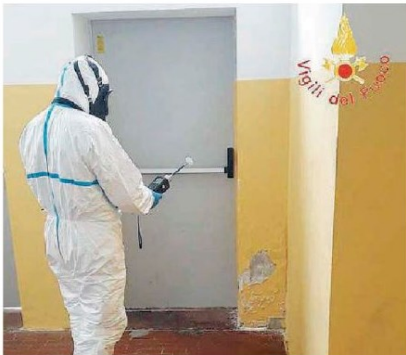
Interventi Un vigile del fuoco al lavoro per ripulire le pareti imbrattate
