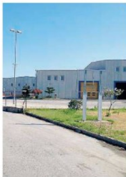
San Leo L'impianto sidernese di trattamento dei rifiuti
