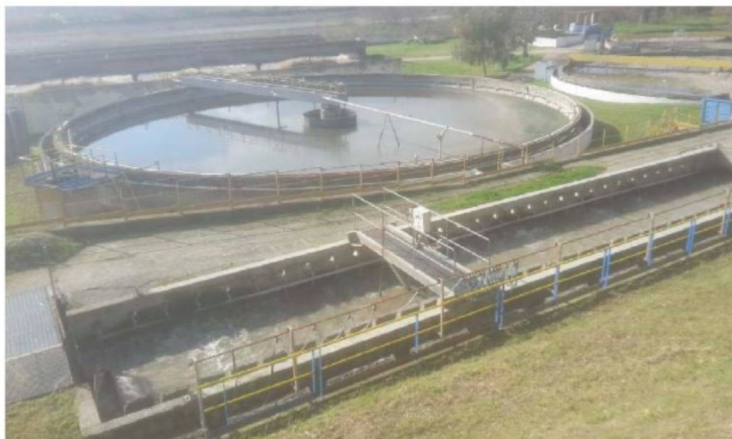
L'impianto Il depuratore del capoluogo, in località Verghello a pochi metri dalle sponde del fiume Corace
