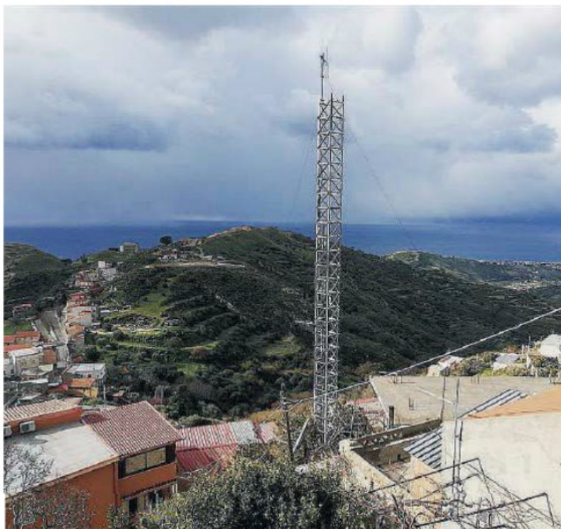
Contrada Lacco Grande L'antenna "sospettata" di inquinamento
