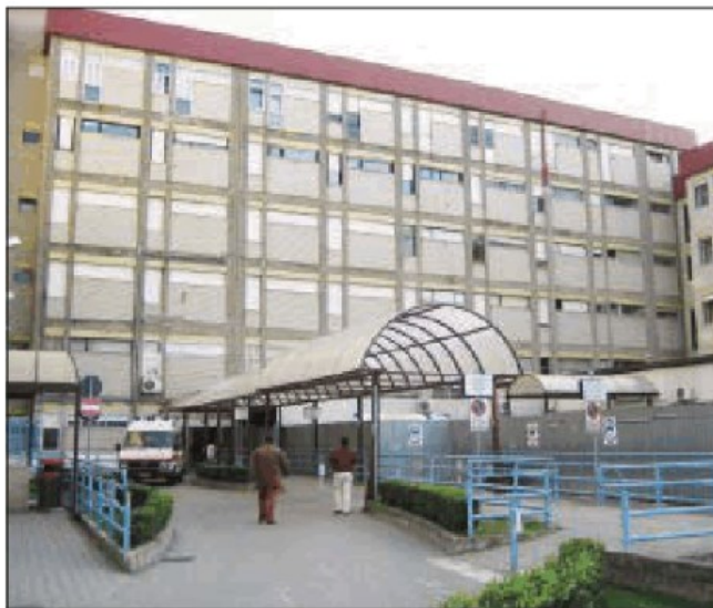
L'ingresso dell'ospedale “Pugliese”
