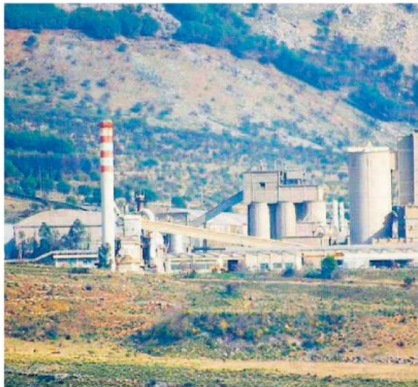
L'ex cementificio L'area dove dovrebbe sorgere l'Ecodistretto
