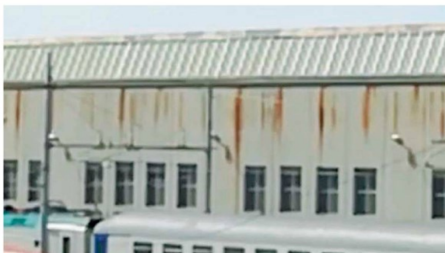
Bonificato Il capannone ferroviario di via Mercalli era ricoperto da lastre di eternit, adesso rimosso
