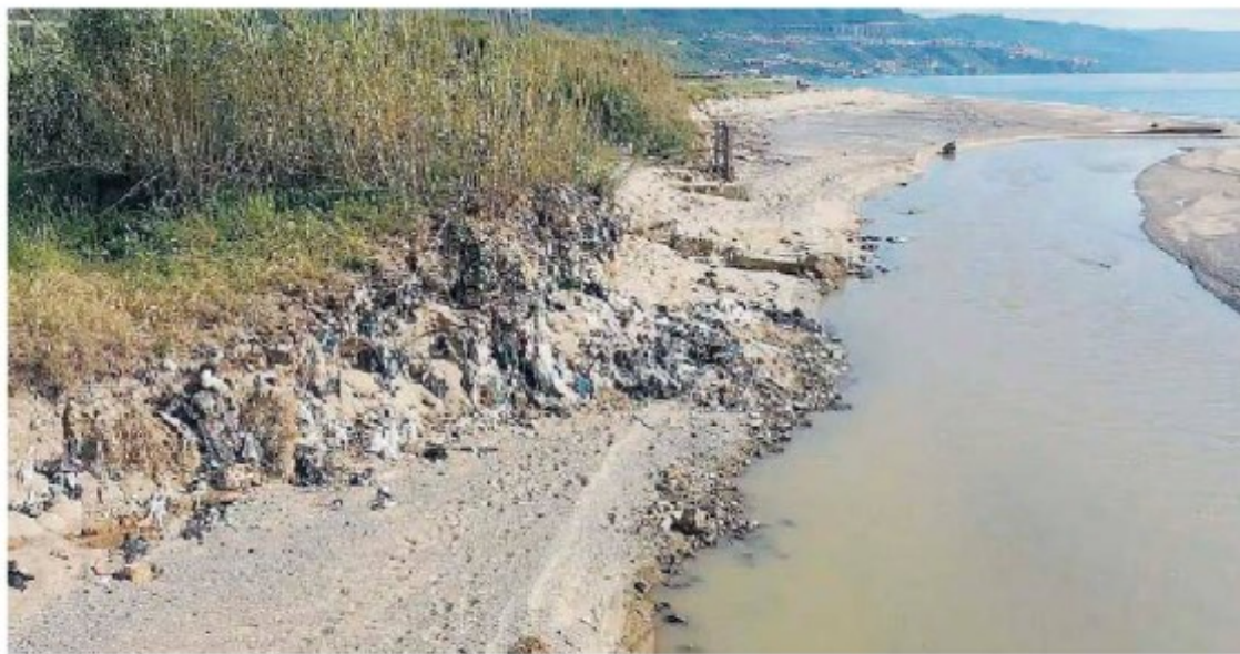
Un anno di attesa Ricondotto il fiume nel suo originario alveo ora si lavora per poter bonificare la zona
