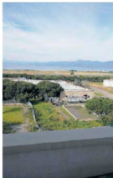
Malumori Una veduta del depuratore di Ravagnese
