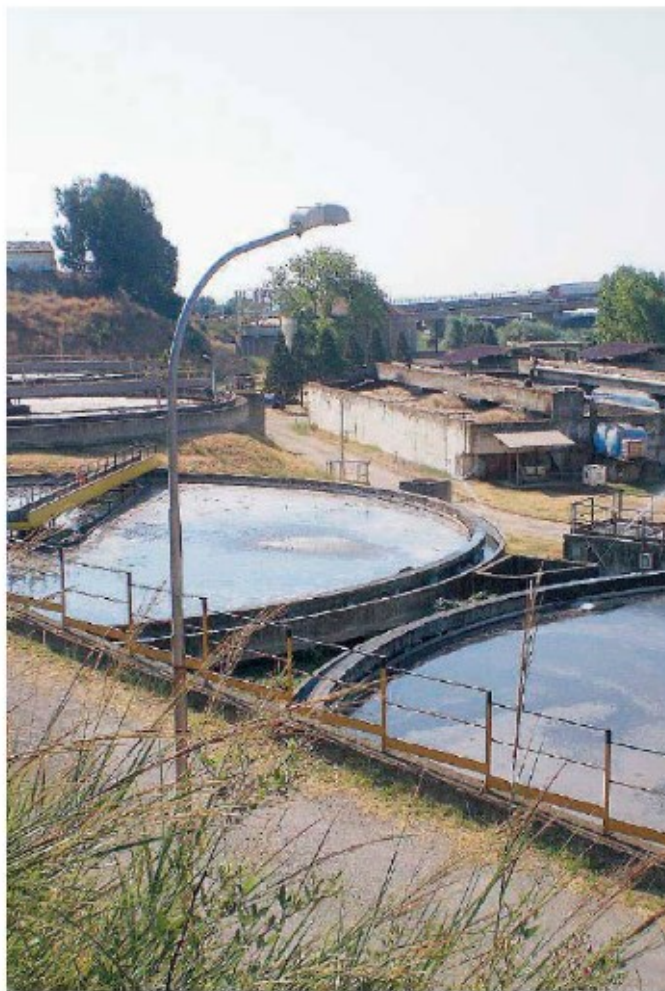
Emergenza ambientale Il depuratore comunale in località Verghello
