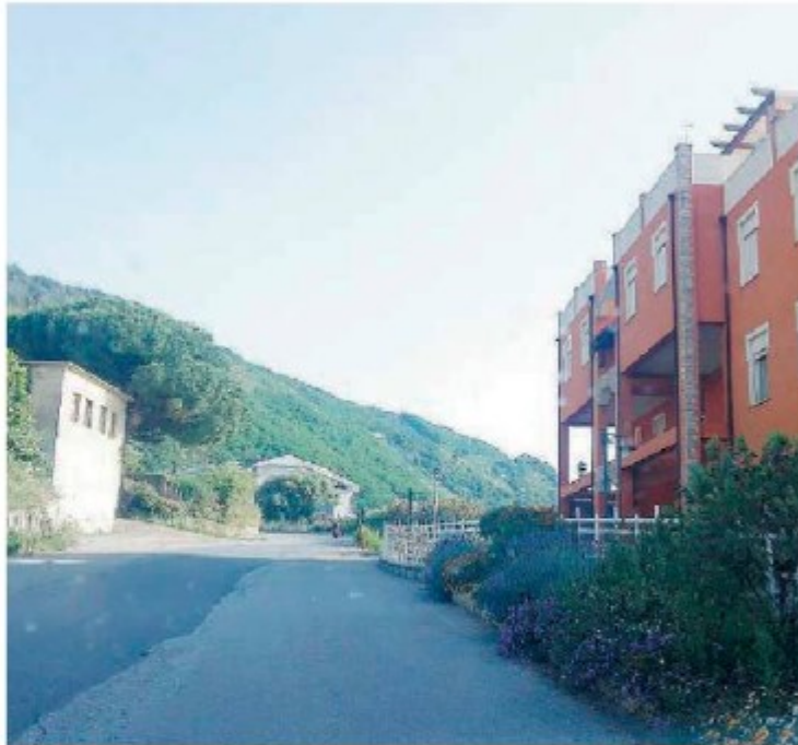
Uno di fronte all'altro L'ex mattatoio e dalla parte opposta il complesso residenziale
