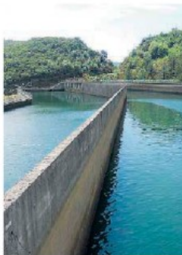
Bene prezioso I pozzi di Alli sono risultati privi di contaminazioni
