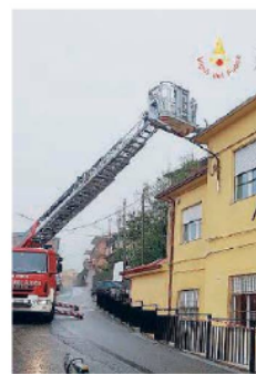
Pentone I pompieri al lavoro sul tetto della scuola elementare
