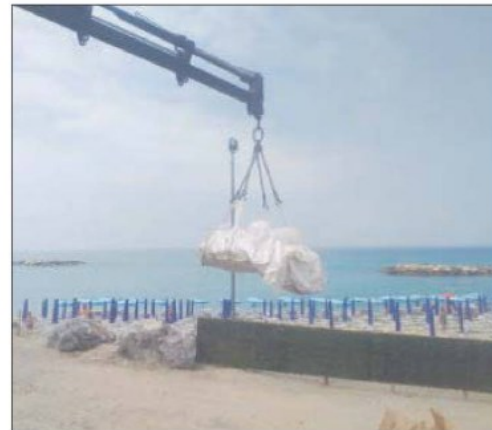
Operai specializzati al lavoro sulla spiaggia paolana
