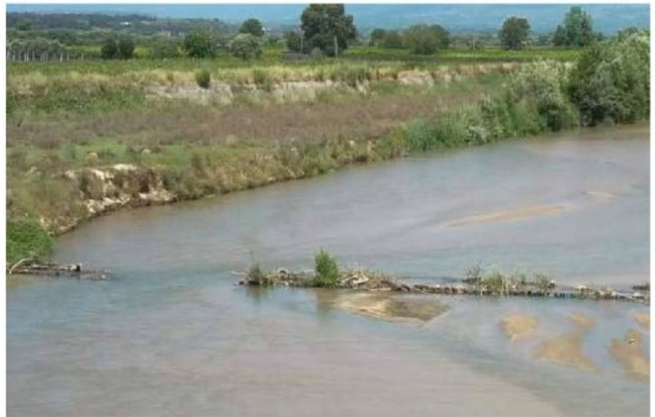
Barriera "filtrante" Non impedisce lo sversamento di acque torbide in mare
