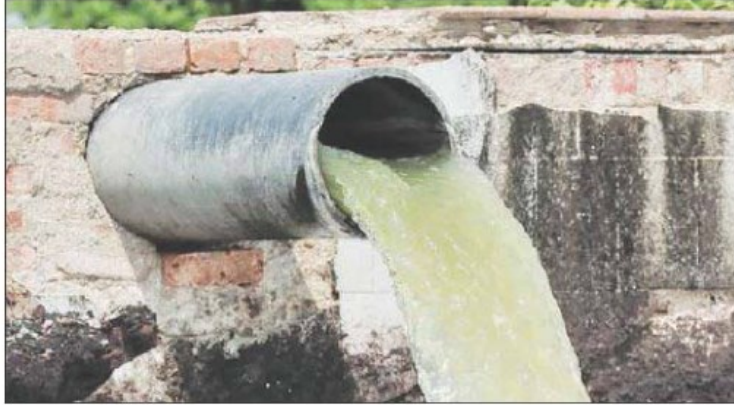
Monitoraggio sugli impianti di trattamento delle acque reflue
