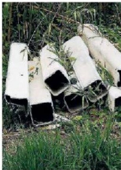
Killer silenzioso L'amianto abbandonato a Belvedere
