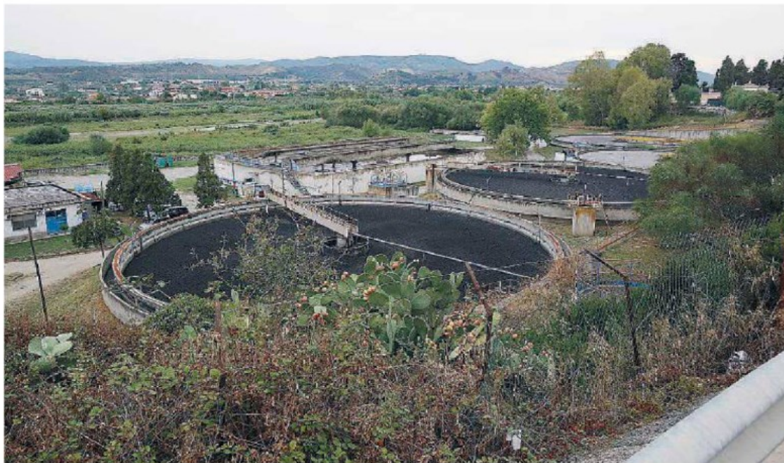
Pericolo liquami L'impianto in località Verghello a pochi metri dalle sponde del fiume Corace
