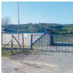
L'unione La nuova struttura ad Acquaro
