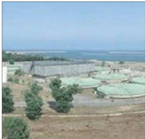
L'impianto di depurazione della Iam
