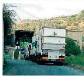
L'autosufficienza del territorio passa dalla trasformazione dell'impianto di Sambatello
