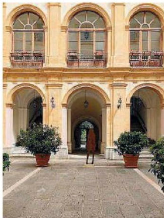
Provvedimento Il Comune ha revocato il divieto
