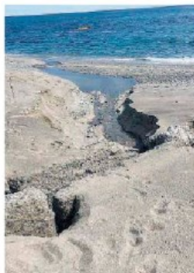
"Pontile" Lo scarico fognario che sbocca in mare
