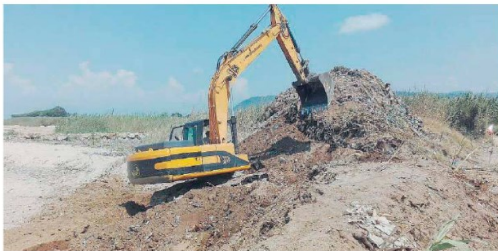
L'intervento Ruspa al lavoro per spostare il corpo dei rifiuti (poi coperti e messi in sicurezza) lontano dal fiume e dal mare
