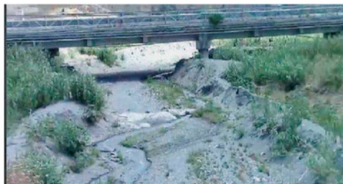
Sant'Elia Il letto del torrente invaso dai liquami
